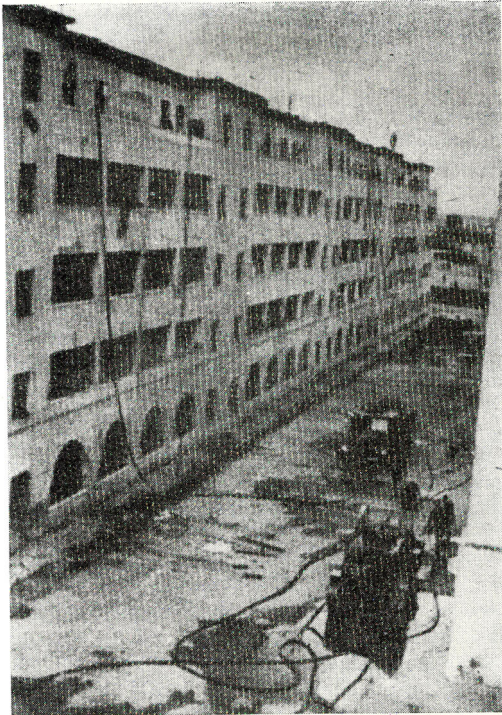
El bloque en que ocurrió el incendio.
